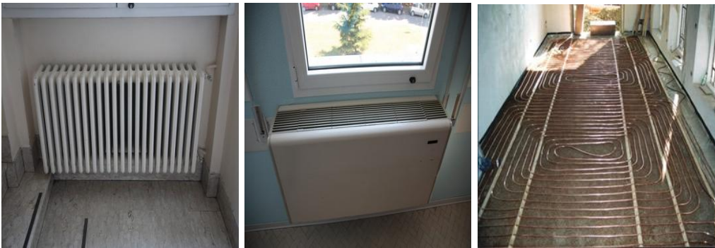
Figura 4: Esempi di radiatori, fancoil e pannelli radianti
