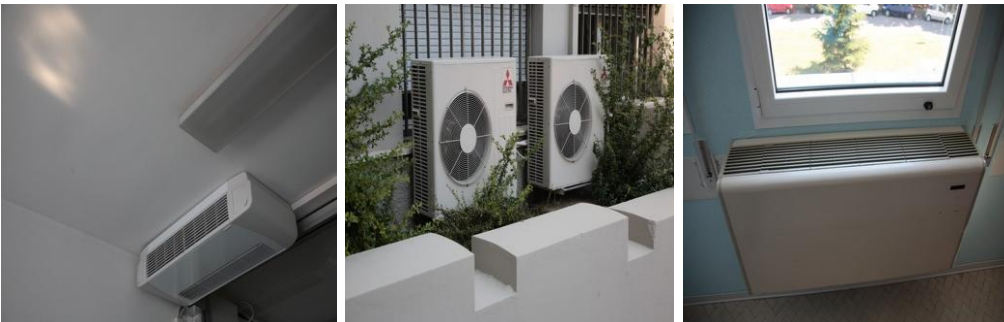
Figura 5: Esempi di split (unità interna ed unità esterna) e fancoil
